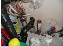
**Drain Waste & Vent Pipes**
