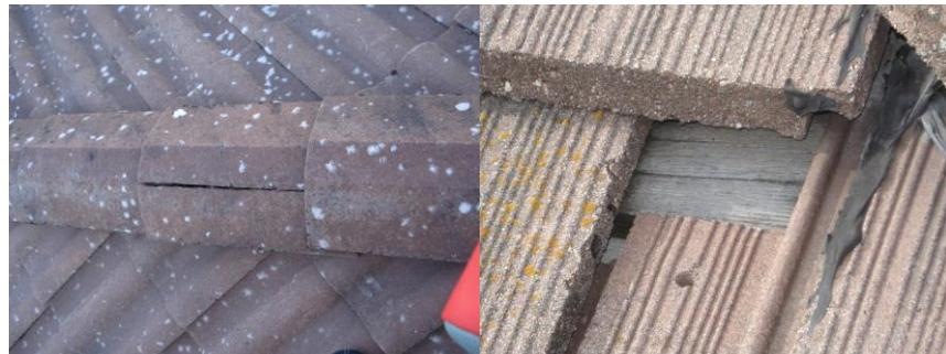
水泥瓦属于比较高档的屋顶材料，不仅因为其本身的造价高，对于铺设该材料的物业，在结构上便有了更高的要求，由于其重量远大于木瓦和沥青瓦，因此传统的屋顶阁楼的支撑 2X4 并不适用，而代之以 2X6，这在某种程度说明了屋业建造的成本、质量更高。水泥瓦使用寿命在 50 年以上，建商更会承诺是终生保障，那么是否意味着安装水泥瓦的屋顶就一劳永逸，其实情况并不尽然，很多在其他屋顶材料会出现的状况，在水泥瓦上会同样产生，而且木瓦、沥青瓦都是两层甚至三层材料对屋顶保护，反观水泥瓦由于自重和构造原因只对屋顶提供单层保护，一旦脱落、开裂、破损，则其下面的防水层 (underlayment) 直接曝露于外，漏水是迟早的了。
