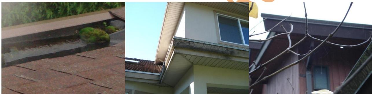
如圖示排水溝內的雜物堵塞是最為常見的問題，也容易解決，業主應該每年秋季檢查清理，以免堵塞、積水。否則其後果是積水從排水溝溢出，浸泡簷板外牆，不但侵蝕簷板，如果長期大量的水從外牆流下至地基，就增加了地下室進水的可能；同時也很大機會滲透過防水材料造成屋頂滲漏。對於外掛式的排水溝，由於其是由多個金屬構件現場焊接、粘結而成，四季冷暖交替加之雨水負荷，長期使用可能出現開焊、粘結劑老化，修繕補漏是必須的。不論是內嵌式還是外掛式的排水溝，都有可能因外長期使用造成其水準的角度變化，積水而不能從落水管排出，重新調整其坡度也在所難免。
