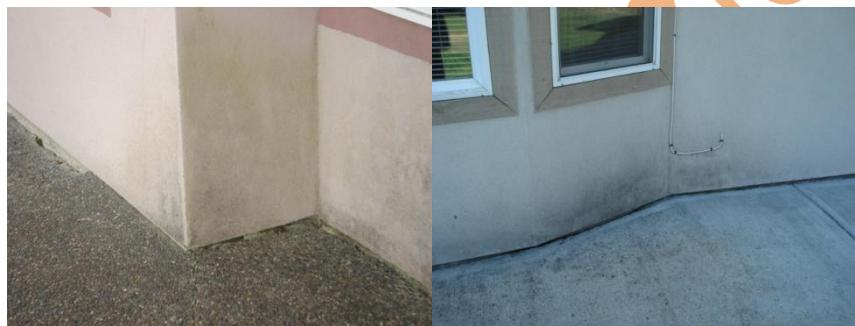
对于传统的灰泥外墙，笔者在验屋过程中遇到的首要问题是墙面裂缝，基本上大部分检查过的灰泥外墙都会有，常见于门窗周围、不同墙面的转角处，主要是由于两种不同材料其膨胀系数不同，在气候热胀冷缩作用
