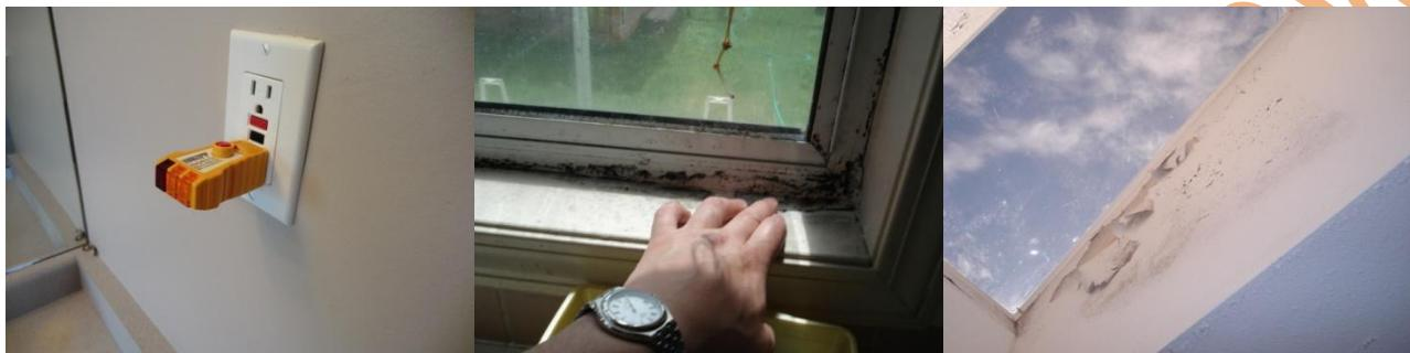
大部分家庭至少会有 2 到 3 个卫生间（浴室），一般在主层客厅附近有个半卫生间(*powder room*)，设有洗手盆和马桶；楼上的过厅和主人房会各有一全套的卫生间包括洗浴和上述设备，个别还安装有按摩浴缸。首先、我们要提及与人身安全相关的设施，大家应该注意到在洗手盆的附近墙面上普遍安装有电源插座(图 1)，方便吹干头发、剃须或电动洗牙，因为水盆台面附近潮湿，这个插座应该是带漏电保护的，即假如正在使用的吹风机不慎掉到水盆里，这个插座会自动断开，不至于造成人身触电。断电、清除危险因素后，我们按回如图插座上的红按钮（reset），电源就又被重新接上，也有可能多个浴室的插座由某一个浴室带按钮的插座控制或者在配电盘控制，老式建筑可能没有断电保护，但普遍可以加装，这一点非常重要，我们验屋是必定要检查的。再有需要加固的活动马桶也经常见到，虽然短期内不会有影响，但马桶下水口的密封蜡长期磨损，可能造成位移、漏水漏气，因此应该立即加固。
