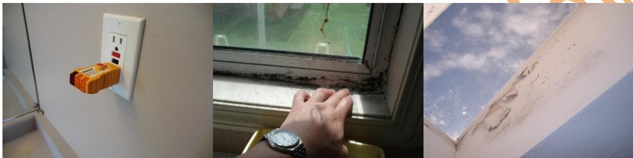
大部分家庭至少會有 2 到 3 個衛生間（浴室），一般在主層客廳附近有個半衛生間(*powder room*)，設有洗手盆和馬桶；樓上的過廳和主人房會各有一全套的衛生間包括洗浴和上述設備，個別還安裝有按摩浴缸。首先、我們要提及與人身安全相關的設施，大家應該注意到在洗手盆的附近牆面上普遍安裝有電源插座(圖 1)，方便吹幹頭髮、剃須或電動洗牙，因為水盆臺面附近潮濕，這個插座應該是帶漏電保護的，即假如正在使用的吹風機不慎掉到水盆裏，這個插座會自動斷開，不至於造成人身觸電。斷電、清除危險因素後，我們按回如圖插座上的紅按紐（reset），電源就又被重新接上，也有可能多個浴室的插座由某一個浴室帶按紐的插座控制或者在配電盤控制，老式建築可能沒有斷電保護，但普遍可以加裝，這一點非常重要，我們驗屋是必定要檢查的。再有需要加固的活動馬桶也經常見到，雖然短期內不會有什麼影響，但馬桶下水口的密封蠟長期磨損，可能造成位移、漏水漏氣，因此應該立即加固。
