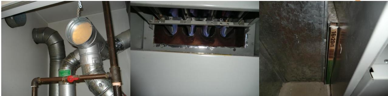
我们首要检查的就是烟囱、送风口(draft hood)的连接，另外、是否设置有燃烧需要的新风补充口，有的安装设备的储藏间使用带格栏漏空的门替代新风口也是可以的。以上这些组件是燃气设备正常燃烧，以及家居安全的基本保障(如图 1)。此外，由于热风炉和热水缸通常共用一个烟囱排出室外，二者连接也是非常重要的。首先要避免过于尖锐的转角可能造成排烟不畅，其次由于热风炉的燃烧输出热量通常比热水缸大，加之往往带有助力排烟，因此要求热水缸烟管到主烟囱的接口要在热风炉接口的上方，如果倒置，会造成小排烟量的热水缸烟管室气，燃烧不充分，以及一氧化碳的产生是潜在风险。与之相结合的是对燃烧器(burner)的检查(图 2)，观察其位置四周的焦糊痕迹，表明整个系统的送风、排烟出现过问题，另外观察火焰是否正常、稳定充分燃烧，跳动、黄色火焰都是存在问题的迹象，如果出现这样的情况就要请专业人员来检查调整，甚至更换设备。对于换热器的观察受到很多的局限，一般不可能看到整个换热器，因此对燃烧室的检查基本局限于此。
