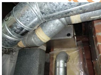
提供热风输送的鼓风机(fan)通常不如整体设备的使用寿命长，短的 5、6 年就有坏掉，另外皮带的老化、开裂也不罕见。我们会观察可见的部分，另外通过其运行判断其的状态，是否需要维修、更换。还有室内的进、出风口、风管都应该定期除尘、清扫，既是健康的需求，也是设备维护的保证。在老旧的建筑里，风管系统包含带有疑似石棉材料(图 4)
