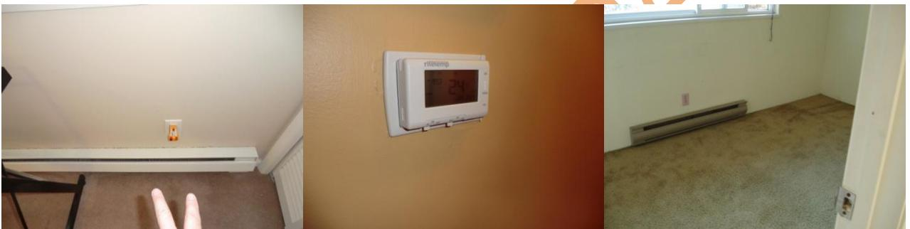
常见的电取暖设备为脚板电暖器(**baseboard**)、埋地辐射散热电热管(**radiant heat**)，广泛应用于镇屋、公寓、独立屋的个别房间和商业建筑。也有电加热的热风炉(**Electric forced air furnace**)和水暖锅炉 (**Electric boiler**)，其工作原理同相应的燃气设备是一致的，但因为要达到通常每小时 100,000BTU 燃气热风炉或锅炉供热能力的电耗高达 30 千瓦，这就需要大约 125 安培的电耗，用电量过大，费用过高，而且对于普通的居民供电也无法达到这样的要求，因此，这两种设备应用并不广泛。
