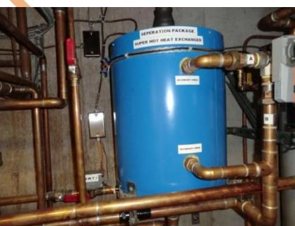
再有，poly-B 管材还同时被应用在锅炉取暖的水管，或者埋在地板，或者连接脚板取暖器。客人往往将锅炉水管和饮用水管混淆，其实用于锅炉水管的 poly-B 才是更应该多加考量的。因为该材料没有气密的防氧层，因此氧气可以透过进入水管，尽管取暖管路是循环封闭的，但由于氧气可以不断进入并保持一定的浓度，且不断通过锅炉金属换热器，所以换热器的氧化腐蚀也就难以避免，锅炉的使用寿命可能被缩短。解决的方法可以通过化学加药处理减缓腐蚀，也可以加装辅助换热器(如图)，从而避免价格昂贵的水锅炉整机的损坏更换。因此，当您遇到有灰管的物业时，大可不必过于困扰，还是要看具体情况而定。了解更多联络作者请登录 [www.comforthomereview.com](http://www.comforthomereview.com)
