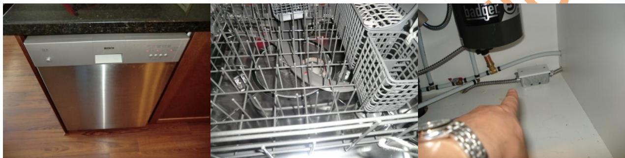
这里我们简单介绍其原理和维护，洗碗机是采用封闭式热循环洗涤，将热水增压经由上下层的冲洗转动棒之喷口射出，间歇性辐射式洗涤餐具，再以清水彻底冲洗餐具，不用抹布，完全切断细菌传播的途径。另外，采用专门的洗涤剂清洗餐具，餐具洗涤后直接烘干，有效杀灭病菌，也无水渍斑痕留在餐具上。在选购洗碗机时，除了考虑价格及容量大小外，建议考虑它的洗涤能力，每次洗水的使用量(通常约在 10—20 公升)、耗电量(约 1-1.5 度)、运转噪音(洗碗机工作噪音以不超过 50 分贝)，时下很多静音设计的机器，此外容器、碗架是否合需求，过滤网拆卸清洗是否容易，都是考量标准。洗碗机效能要发挥的好，专业安装是首要，进水、排水的位置通常靠近厨房水槽下方便于进水管和排水管的配置，同时要远离炉头等热源，避免导致机体过早老化。电源安装一般在橱柜内，尽量位于橱柜内壁而不是柜底面，假使水槽漏水也不至于很快造成其短路。
