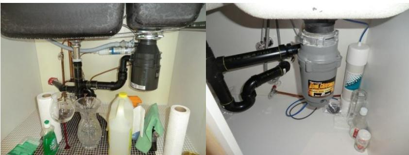
碎骨機的啟動開關通常位於離水槽不遠的牆壁上或水槽的下方櫥櫃內，雖然市場上同類產品的品牌眾多，但通常馬力在  $1/3\text{hp} \sim 1\text{hp}$  之間，馬達轉速約一至二千轉/分，憑藉著高轉速可瞬間將食物殘渣打碎，順著水流排入下水管。碎骨機的使用要點是在啟動和關閉前都要有水流，這一點非常重要，既可以保證攪碎的顆粒被水流沖走，也可以降低設備高速摩擦產生的熱量，避免設備部件受損。因此，應該是提前開水，再啟動設備，當聽到設備攪拌聲連貫、一致後，表明雜物基本被排掉，再關閉設備，最後關水。再有，碎骨機是設計用來攪碎一般的食物殘留及雞、鴨、魚等細小骨頭，因此應該避免將大骨頭、牡蠣殼、金屬或塑膠物品放入攪碎，以防損壞設備。對於高油脂及高纖維食物也禁止使用碎骨機處理，因為大量的油脂及高纖維很容易纏繞、粘結在機體內。
