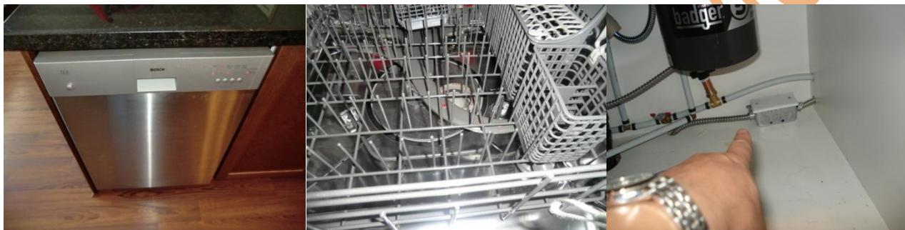
這裏我們簡單介紹其原理和維護，洗碗機是採用封閉式熱迴圈洗滌，將熱水增壓經由上下層的沖洗轉動棒之噴口射出，間歇性輻射式洗滌餐具，再以清水徹底沖洗餐具，不用抹布，完全切斷細菌傳播的途徑。另外，採用專門的洗滌劑清洗餐具，餐具洗滌後直接烘乾，有效殺滅病菌，也無水漬斑痕留在餐具上。在選購洗碗機時，除了考慮價格及容量大小外，建議考慮它的洗滌能力，每次洗水的使用量(通常約在 10—20 公升)、耗電量(約 1-1.5 度)、運轉噪音(洗碗機工作噪音以不超過 50 分貝)，時下很多靜音設計的機器，此外容器、碗架是否合需求，過濾網拆卸清洗是否容易，都是考量標準。洗碗機能要發揮的好，專業安裝是首要，進水、排水的位置通常靠近廚房水槽下方便於進水管和排水管的配置，同時要遠離爐頭等熱源，避免導致機體過早老化。電源安裝一般在櫈櫃內，儘量位於櫈櫃內壁而不是櫃底面，假使水槽漏水也不至於很快造成其短路。
